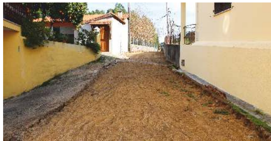
Pavimentação e saneamento da rua do Lodeiro – Fragalhinha
