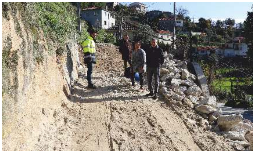
Construção de Muro de Suporte / Alargamento e Requalificação da Rua da Tapa - Seixinhos
