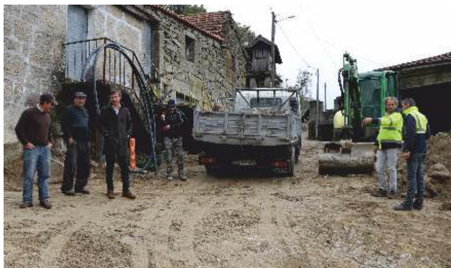
Instalação da rede de saneamento de básico em Penalonga-Canedo -investimento de 350 mil €
