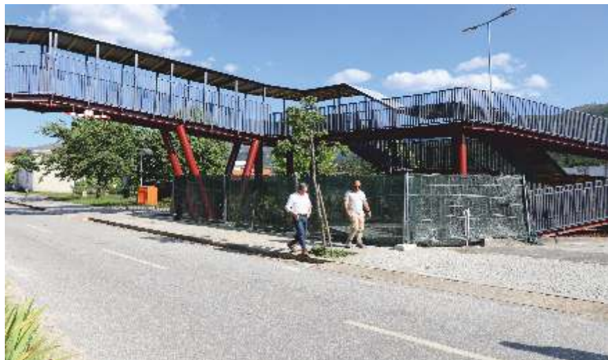
Conclusão da reabilitação da Ponte Pedonal - Requalificação e Modernização da Escola Básica de Cerva
