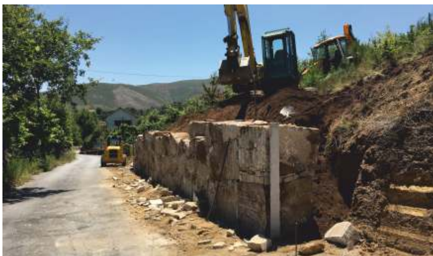
Construção de Muro de Suporte Portela de Santa Eulália
