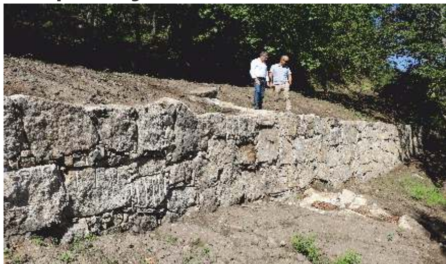
Estabilização de Talude - Na estrada Chão da Cruz - Reboreça
