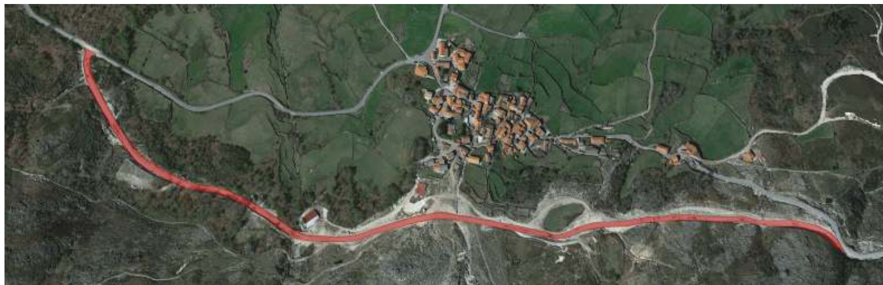
Pavimentação da Variante de Macieira - Investimento previsto: 175.394,75€
