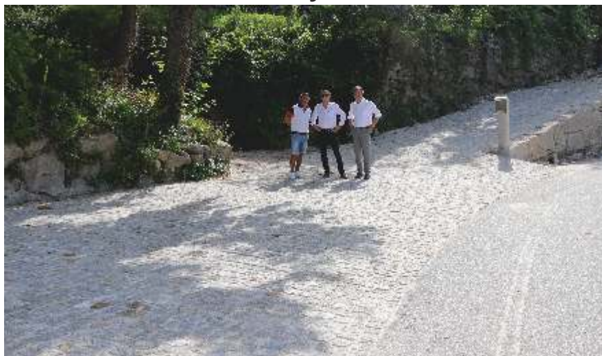
Calçamento e Construção de Muro de Suporte - Alvite
