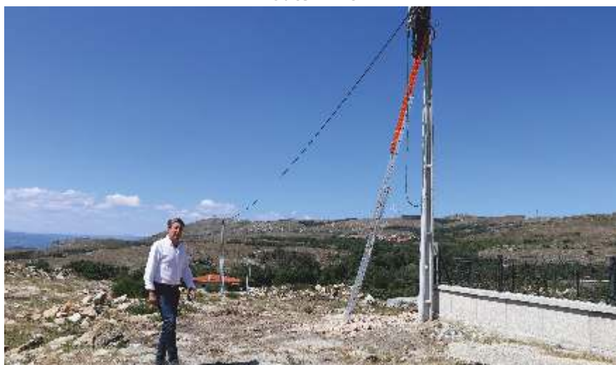
Instalação de novo ramal de eletricidade - Alvadia
