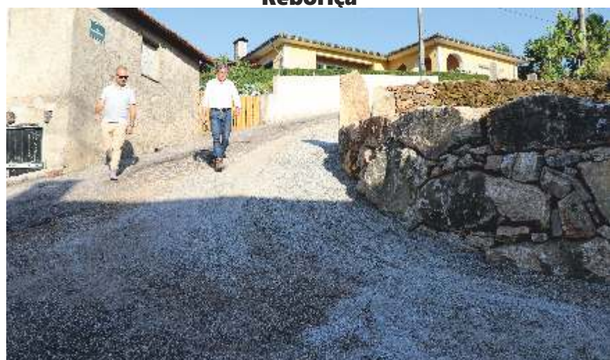
Retificação e Alargamento da Rua Tapadas do Ribeiro - Balteiro
