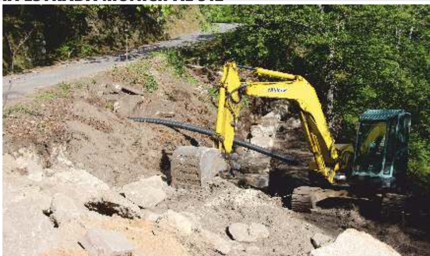
CONSTRUÇÃO DE MURO DE SUPORTE NO CHÃO DA CRUZ – SALVADOR
