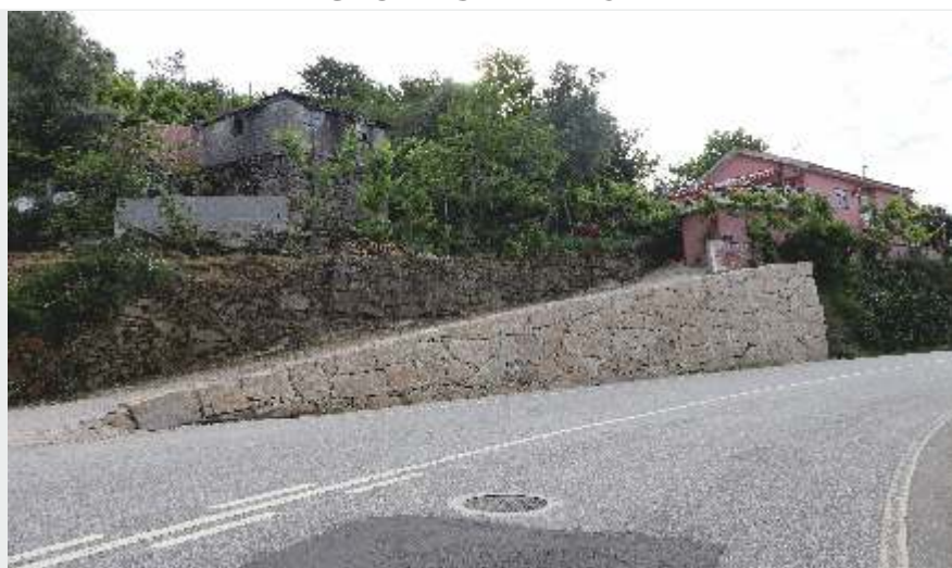
CONSTRUÇÃO DE MURO EM ALVITE – CERVA
