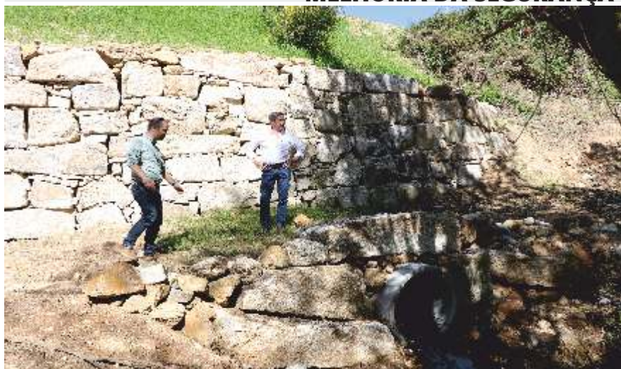
CONSTRUÇÃO DE MURO DE SUPORTE EM CANEDO
