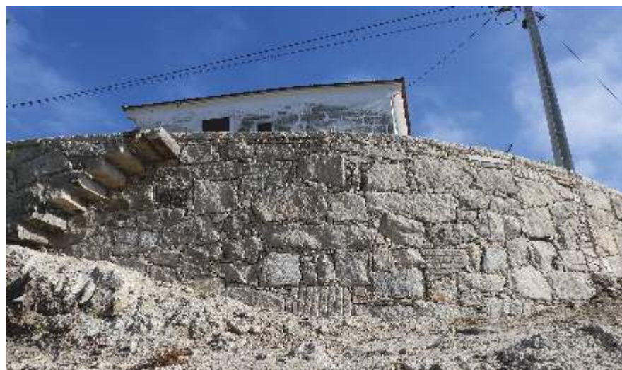
CONSTRUÇÃO DE MURO NO CABO DA COSTA – CERVA
