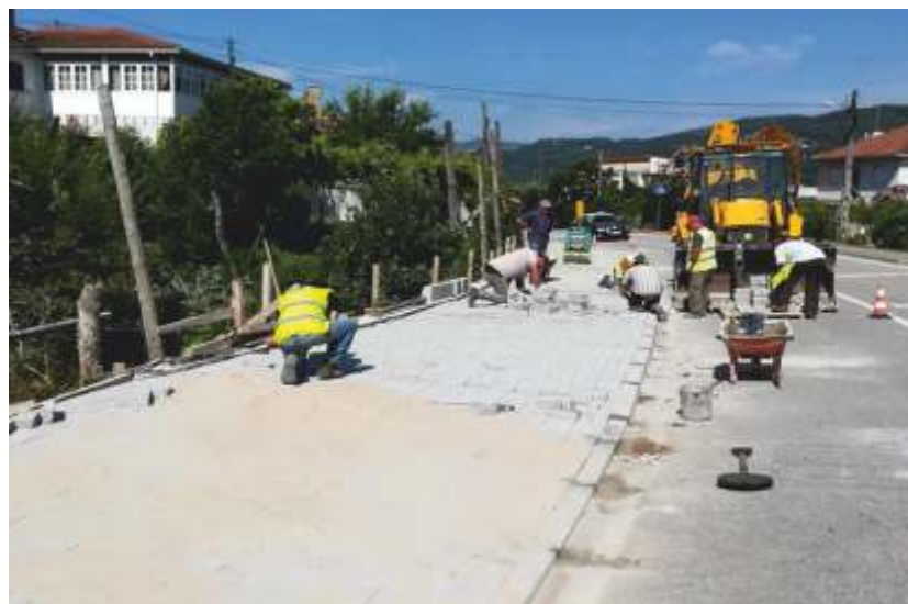
EXECUÇÃO DE PASSEIOS – BALTEIRO
