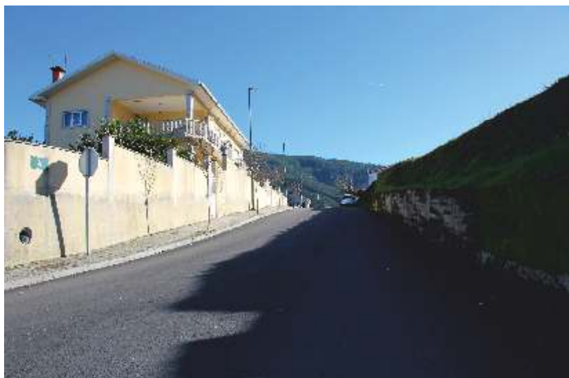
PAVIMENTAÇÃO DA RUA DA IGREJA – SALVADOR
