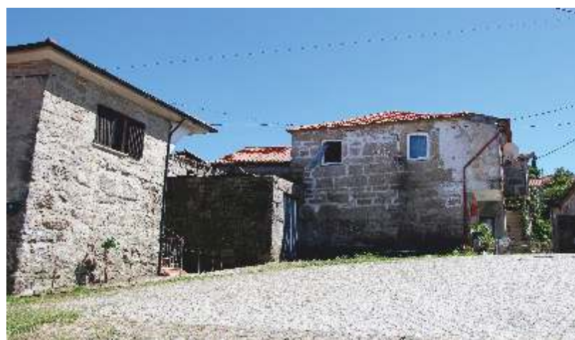
Saneamento de Escarei
