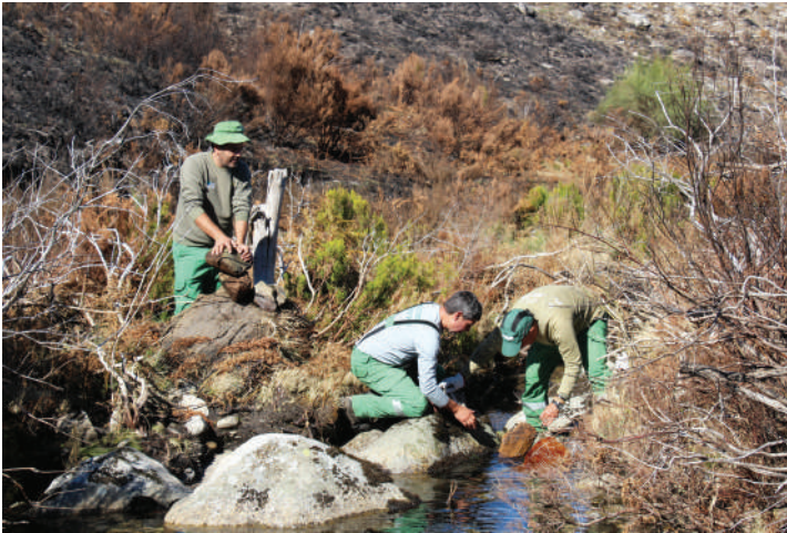
Construção de açudes
