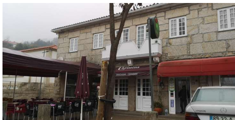
72 | Fachadas com toldo de sombreamento associado ao estabelecimento comercial
