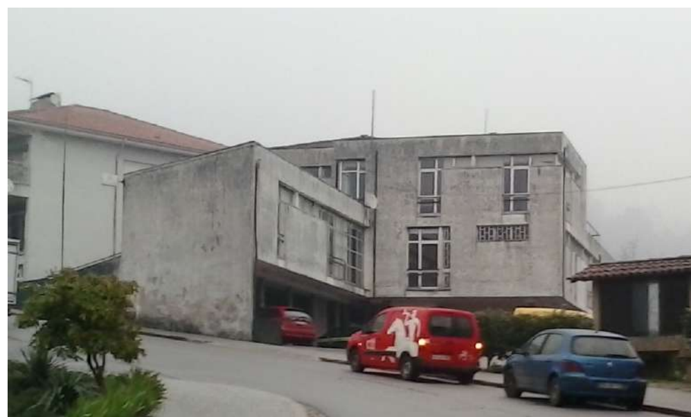
126 | Edifício da GNR
