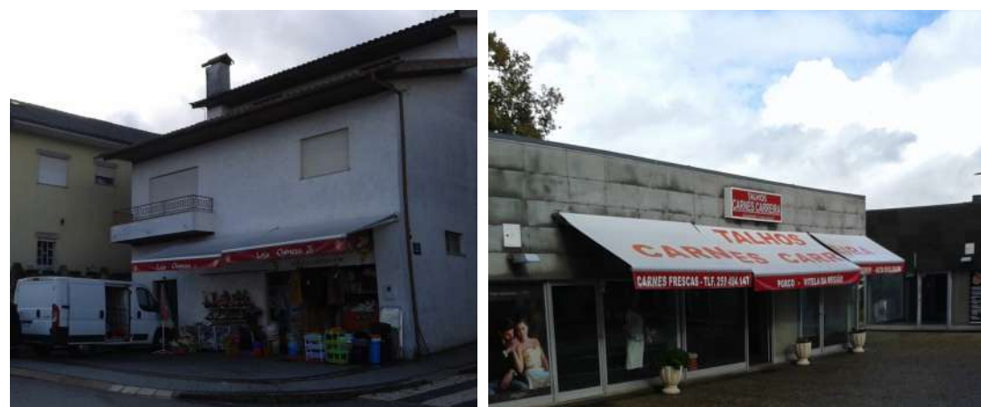
85 | 86 | Fachadas com toldo de sombreamento associado ao estabelecimento comercial
