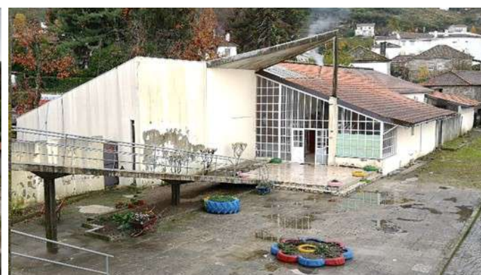
169 | Estado atual do edifício
