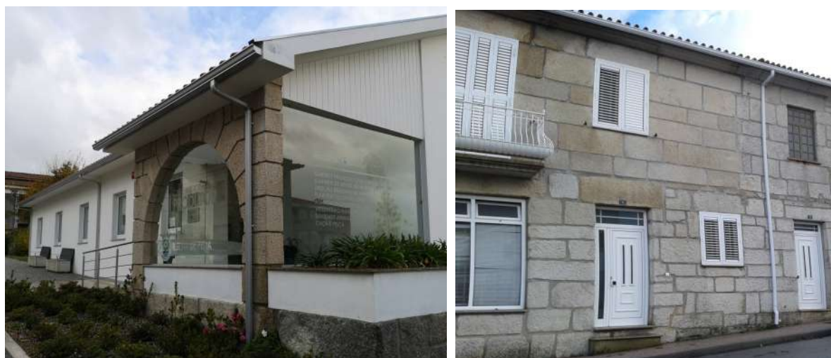
78 | 79 | Coberturas com beirado e caleira
