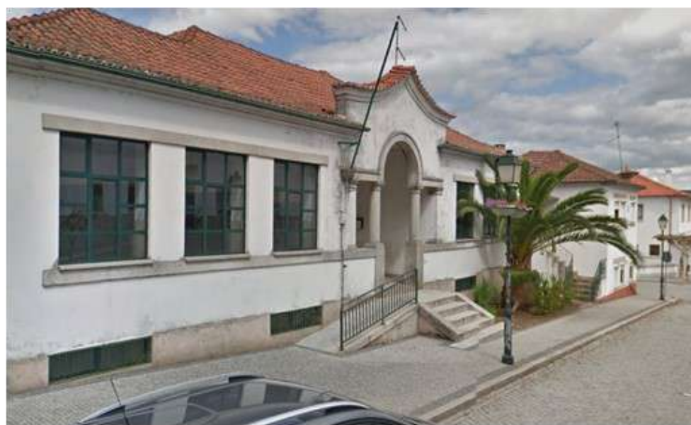
166 | Edifício da antiga Escola Primária
