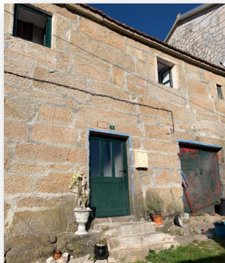
Figura 29 - Coberturas com e sem beirado e caleira
