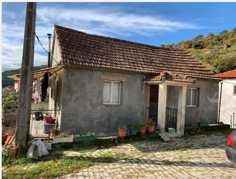
Figura 28 - Cobertura com deformações e espécies infestantes
