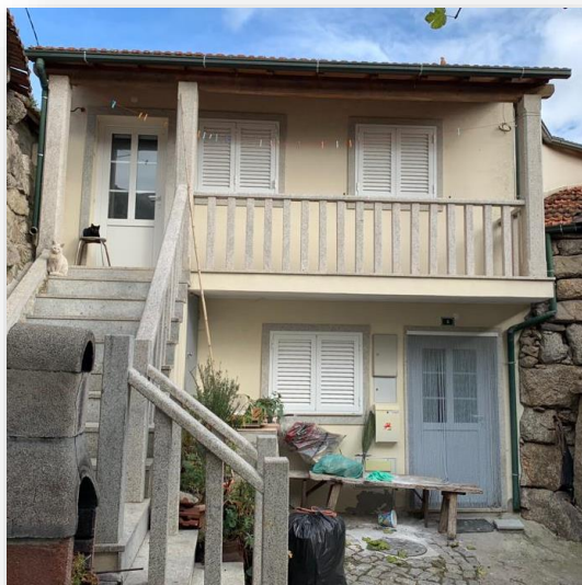
Figura 29 - Coberturas com e sem beirado e caleira
