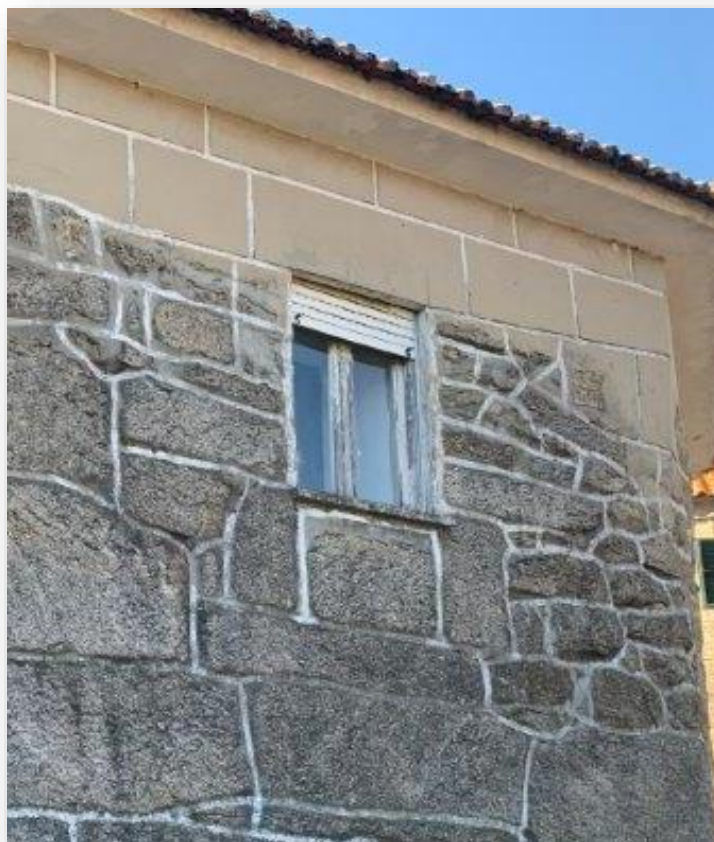
Figura 35 - Caixilharias degradadas
