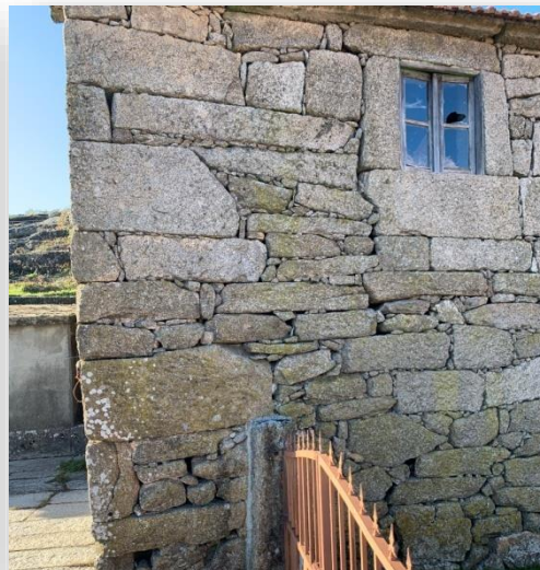
Figura 33 - Caixilharias degradadas
