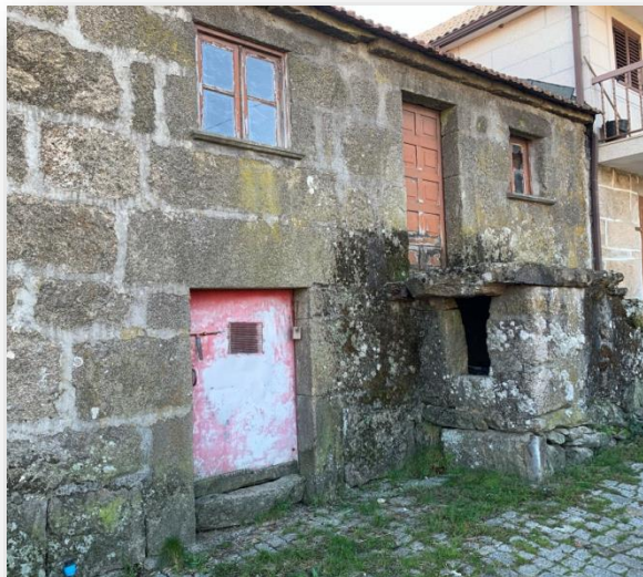
Figura 33 - Caixilharias degradadas
