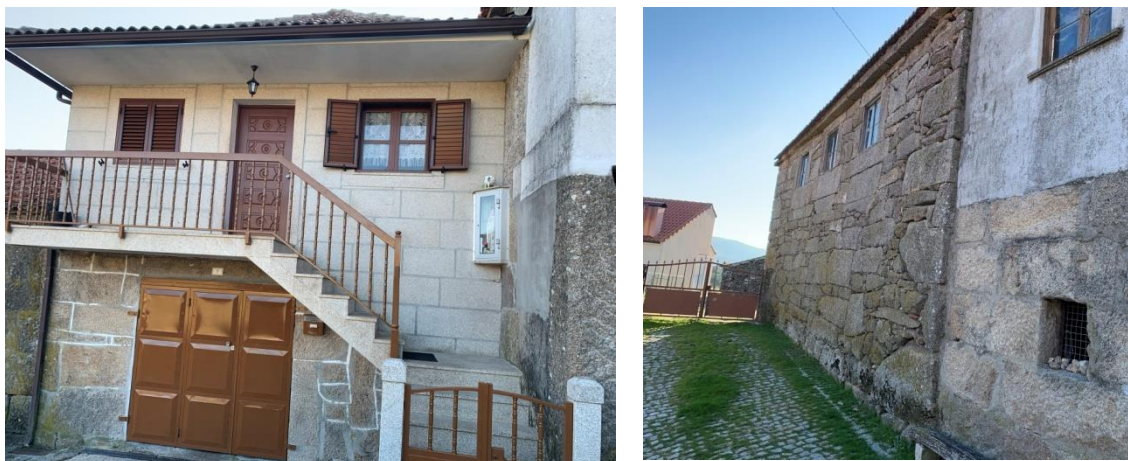
Figura 29 - Coberturas com e sem beirado e caleira
