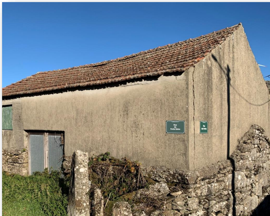
Figura 28 - Cobertura com deformações e espécies infestantes
