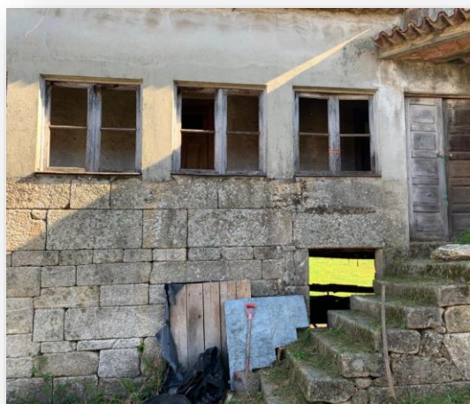
Figura 37 - Caixilharias degradadas
