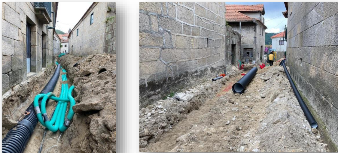
Figura 39 - Obras de requalificação do espaço público em Limões
