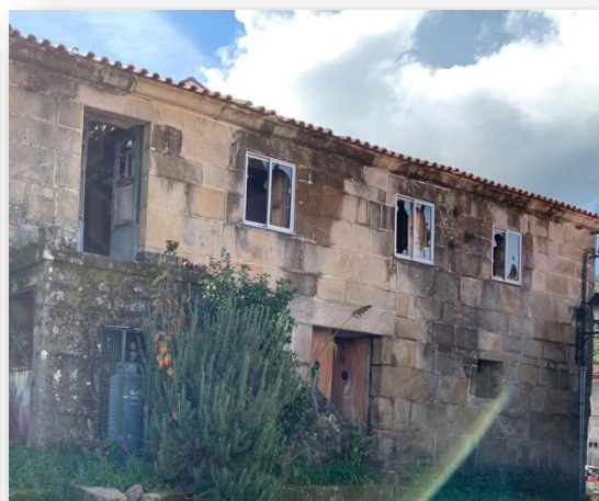
Figura 37 - Caixilharias degradadas
