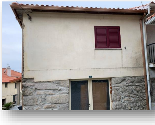
Figura 28 - Coberturas com e sem beirado e caleira
