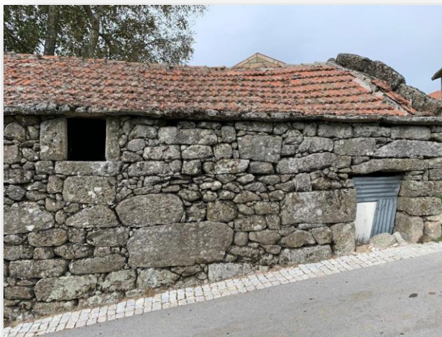
Figura 27 - Cobertura com deformações e espécies infestantes
