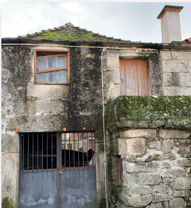
Figura 32 - Caixilharias degradadas
