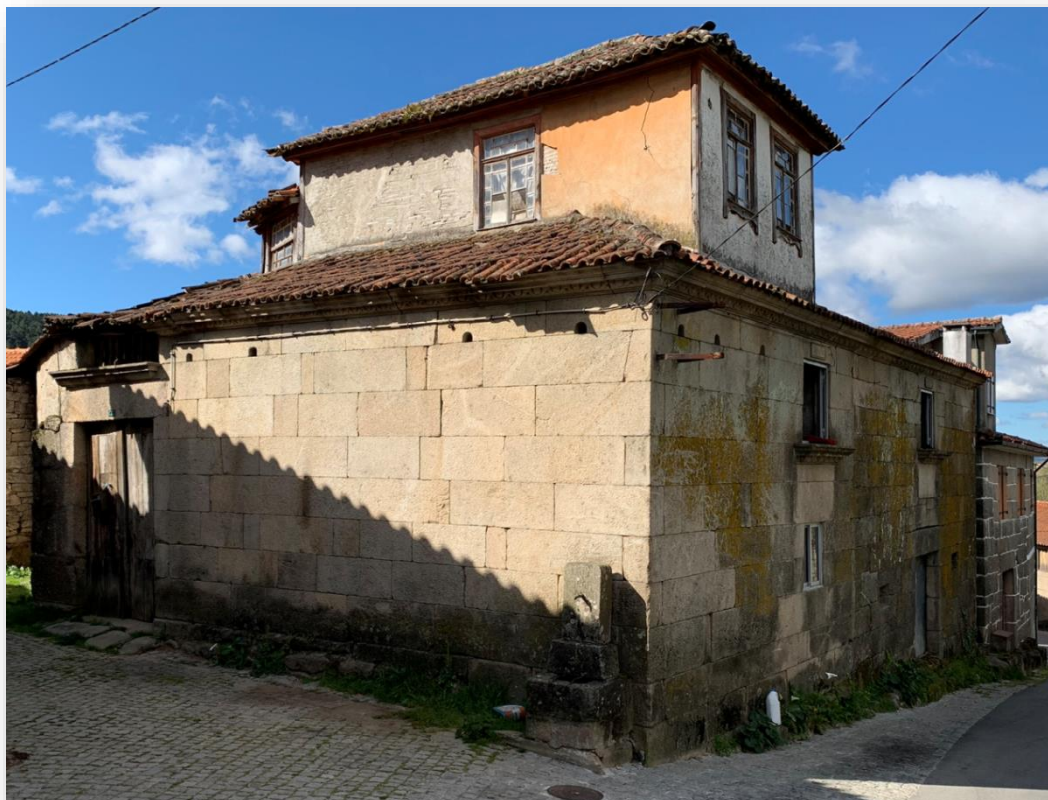
Figura 33 - Cobertura com deformações e espécies infestantes
