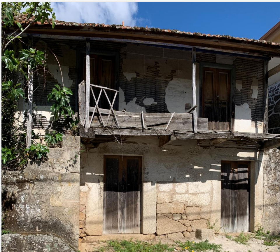
Figura 37 - Caixilharias degradadas
