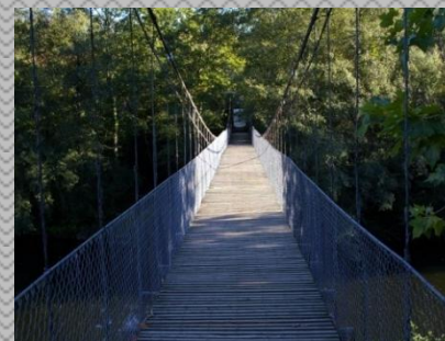
Ponte de Arame – Tabuleiro
