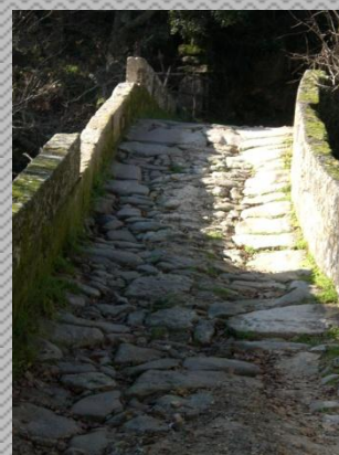
Ponte do Lourêdo – Pormenor da Calçada
