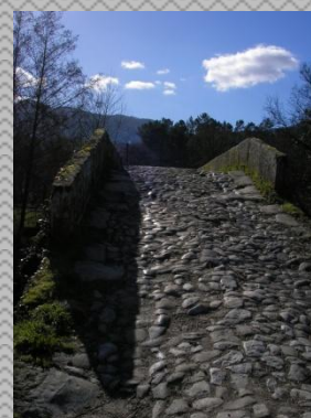
Ponte de Alvite – Pormenor da Calçada
