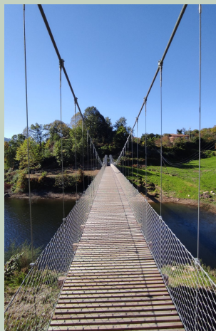
4 Ponte de Arame
